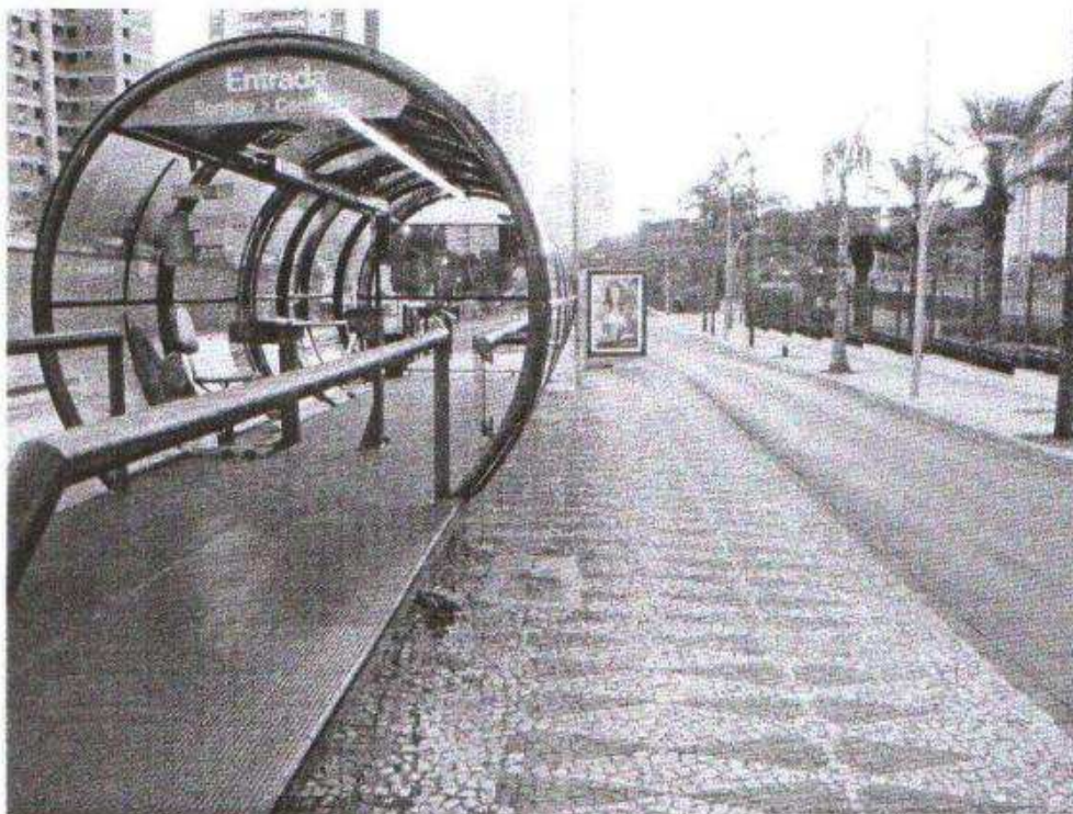
Foto 01 – Estação tubo, com acesso de passageiros e posto de trabalho do cobrador.
