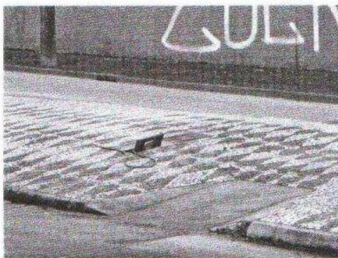
Foto 11 – local utilizado precariamente para lavagem das mãos (mangueira), em via pública.
